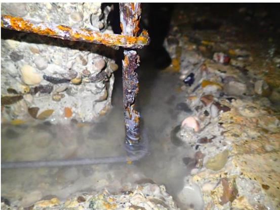
Bild 3: Beispielhafte Bewehrungskorrosion an einem Stützenfuß infolge Chlorideinwirkung (Quelle: Hochschule München)
