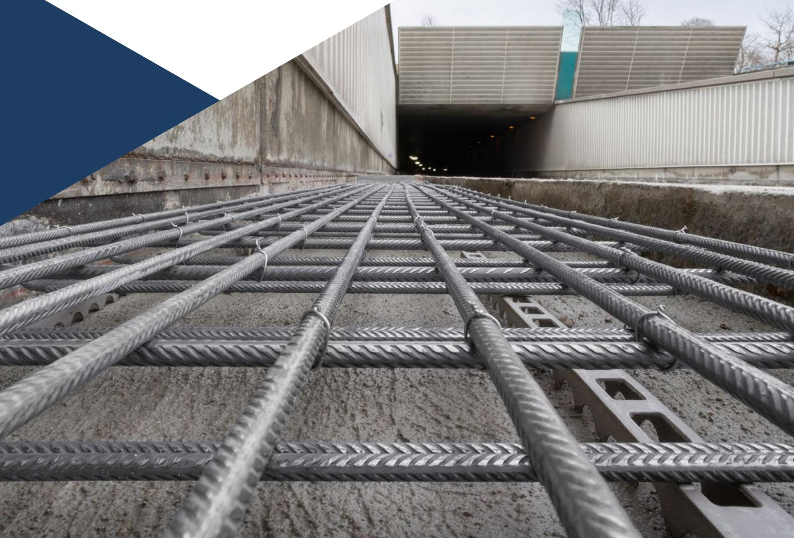
Der kostengünstige nichtrostende Betonstahl Top12 bietet dank einem Chromanteil von über 12 Prozent einen zuverlässigen Schutz gegen Korrosion und macht Bauten siebenmal langlebiger. Instandsetzungen werden vermeidbar, die Lebenszykluskosten sinken markant.
