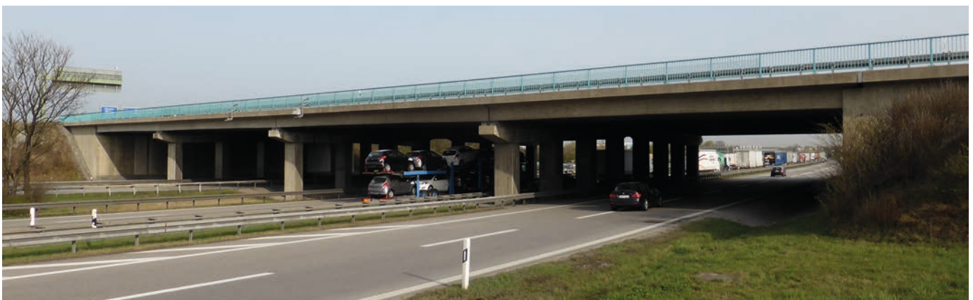
Bild 2 AK München Ost, BW 17, Baujahr 1973 und Verbreiterungen von 1999 bzw. 2004 Highway interchange Munich East, years of construction: 1973, 1999, 2004
