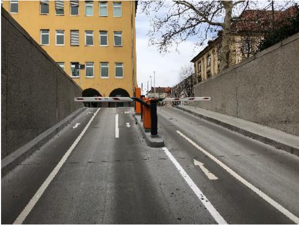
Bild 7: Rampe nach der Instandsetzungsmaßnahme mit Top12 (Quelle: Swiss Steel AG)
