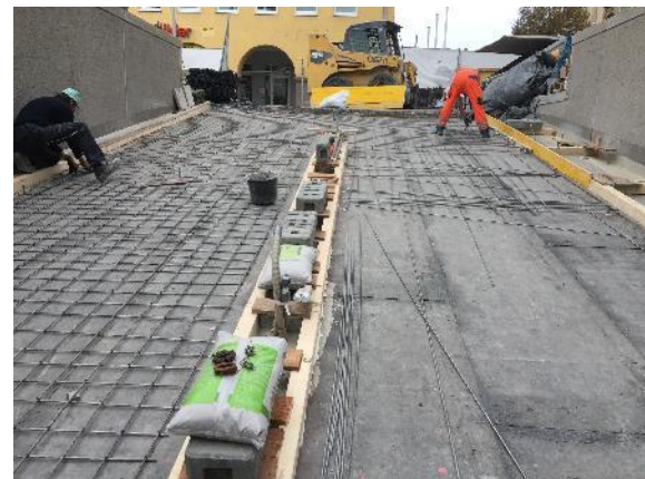
Bild 6: Instandsetzung einer Rampe mit Top12 (Quelle: Bräuning + Partner mbB, Bamberg)
